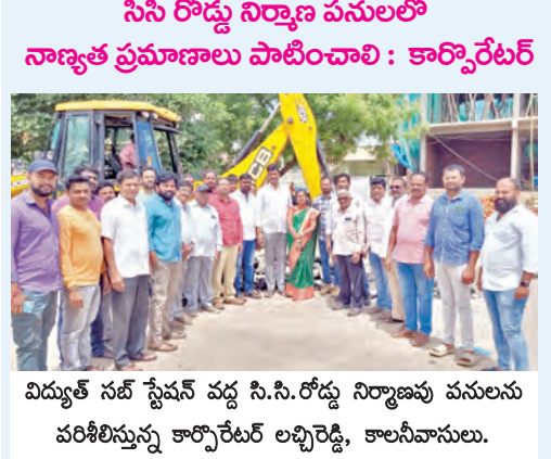
విద్యుత్ సబ్ స్టేషన్ వద్ద సి.సి.రోడ్డు నిర్మాణపు పనులను పరిశీలిస్తున్న కార్పొరేటర్ లభిరెడ్డి, కాలనీవాసులు.
